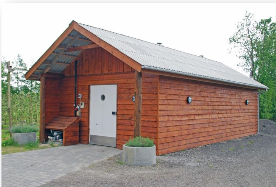
Kølerum i frugtplantage beklædt med douglasbrædder
